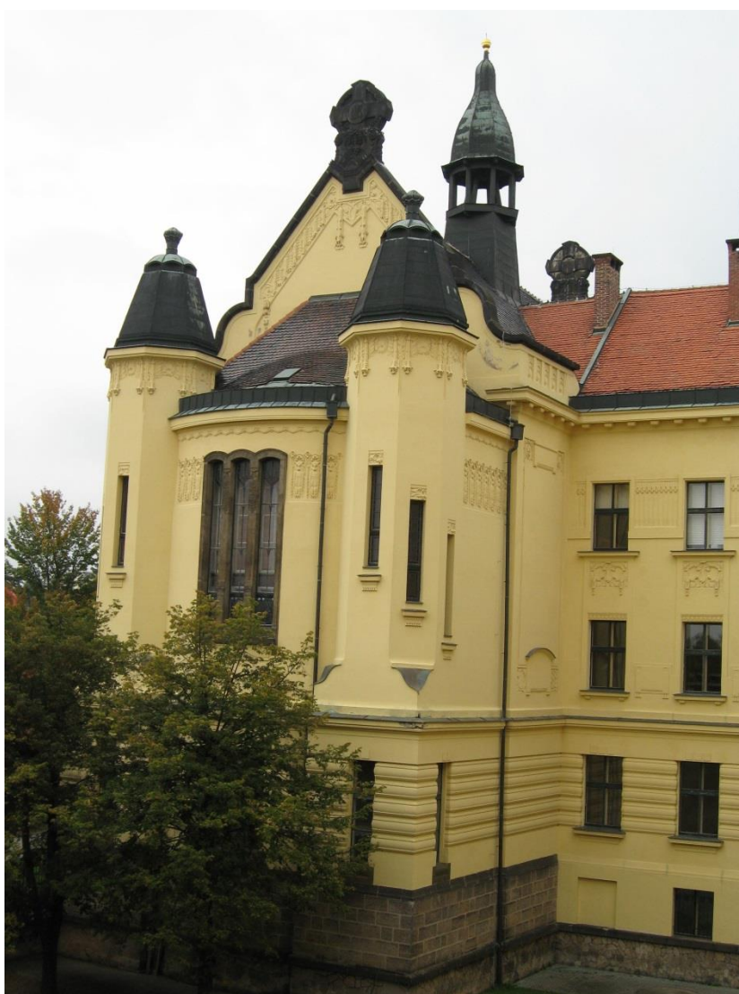
Obrázek 1 Budova školy pohled ze dvora
