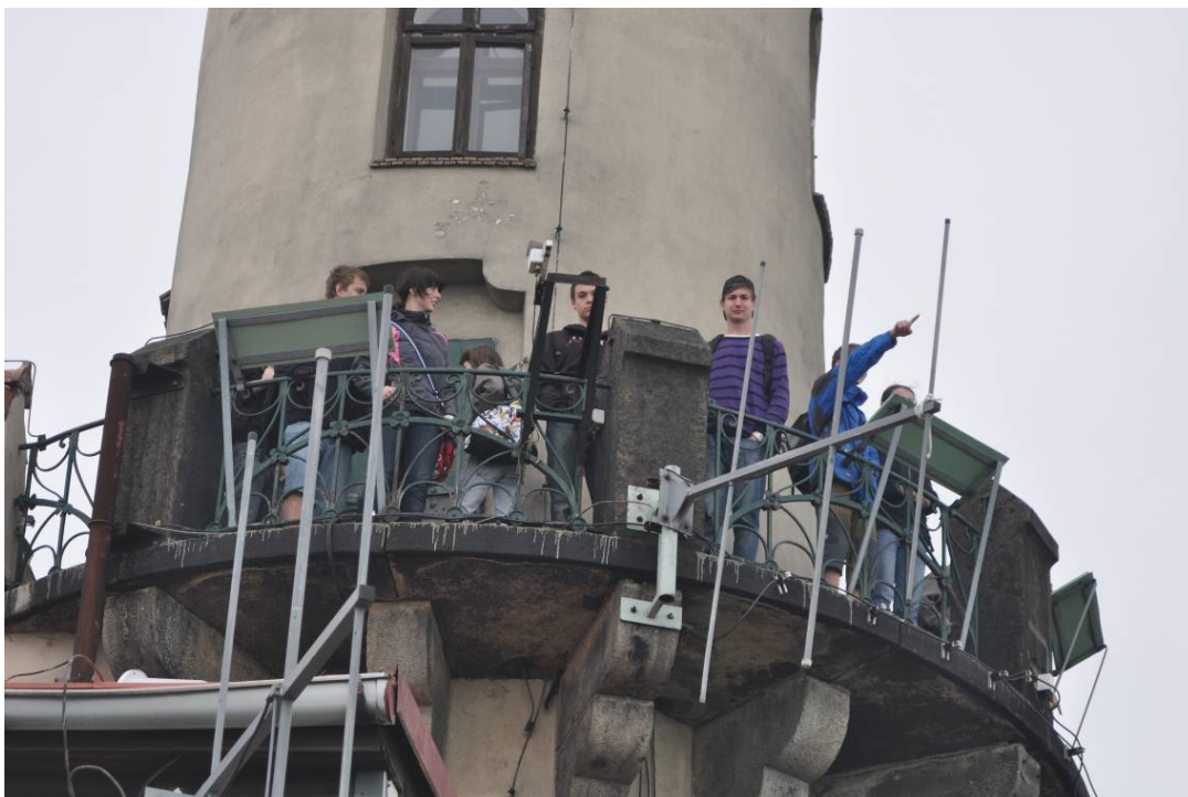
Obrázek 13 Meteorologická stanice na Milešovce – exkurze
